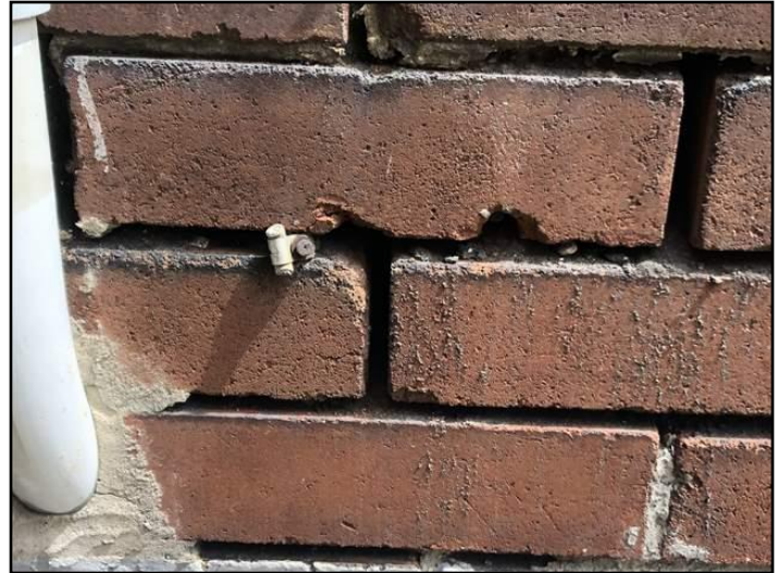
29. Mortar deteriorating
