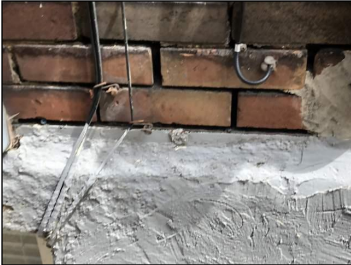
28. Mortar deteriorating
